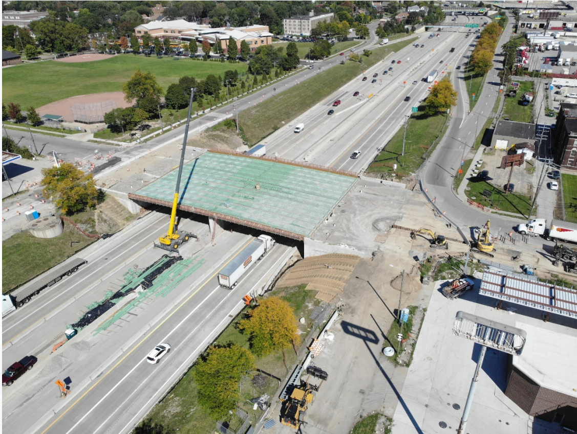
Corredor de la I-75: Puente en Clark Street
